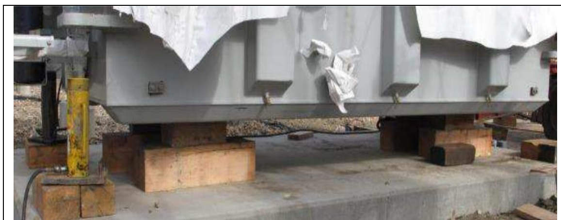
شکل (۱-۶): استفاده از بلوک های مهارکننده جهت مهار ترانسفورماتور هنگام کشیده شدن
